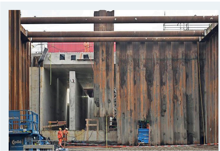
De damplanken tussen de twee bouwkuipen werden vorige week verwijderd. FOTO JAN WESSELS
